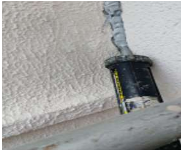
Figura 10 – Equipamento de Auxílio
